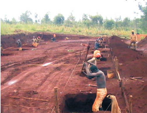
Kopanie fundamentów pod dom rekolekcyjny
